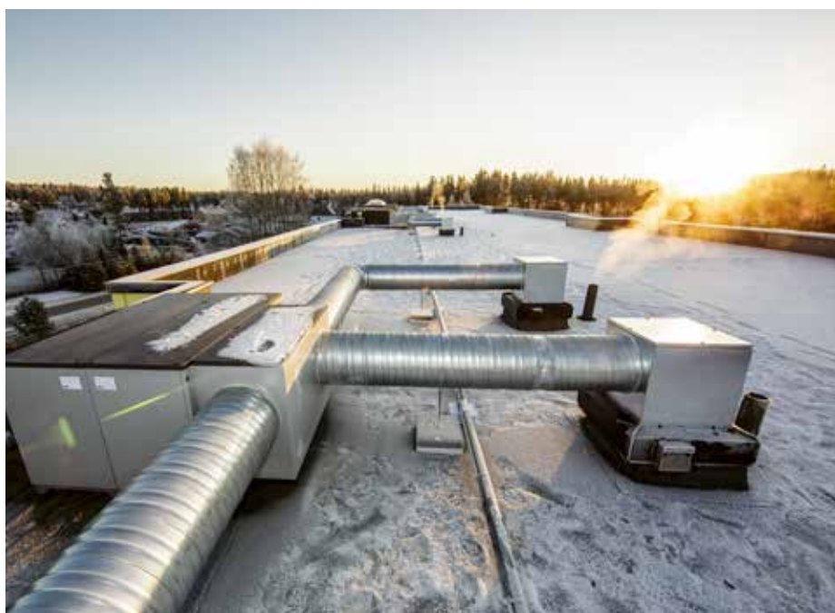
▲ AGGREGAT: Tre Cityvexer med tilhørende varmepumpe er montert på hvert tak. Cityvexen består av to moduler, den ene står på taket, den andre innvendig i trappeoppgang.
